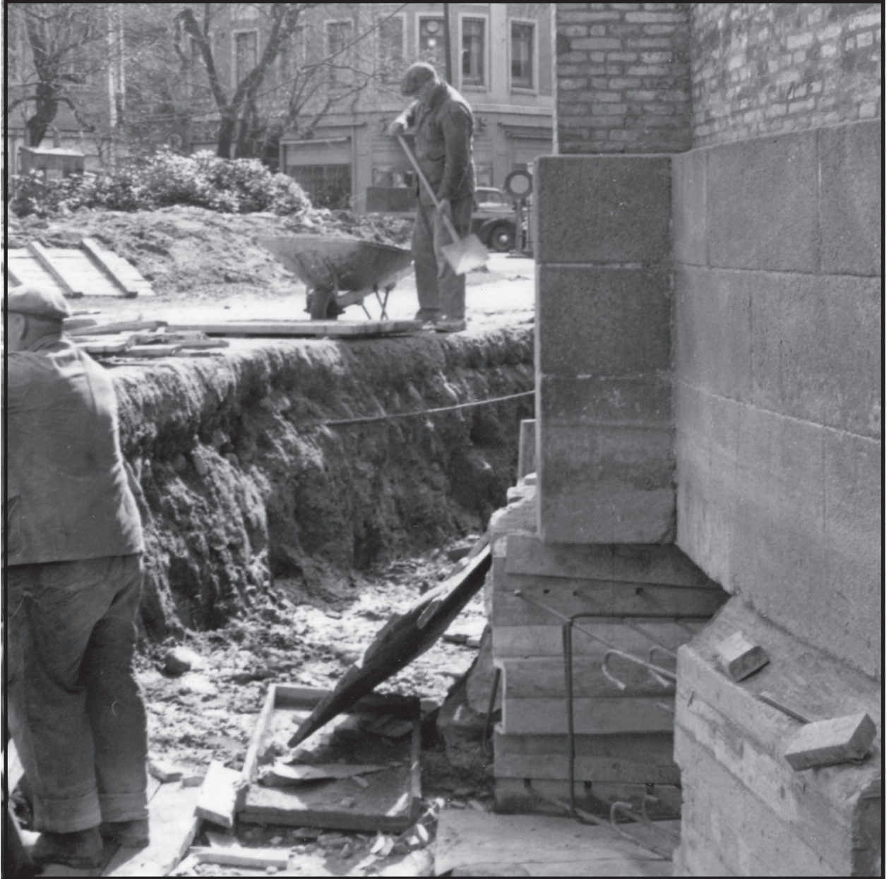
Grundförstärkningsarbeten år 1954. GSM.
