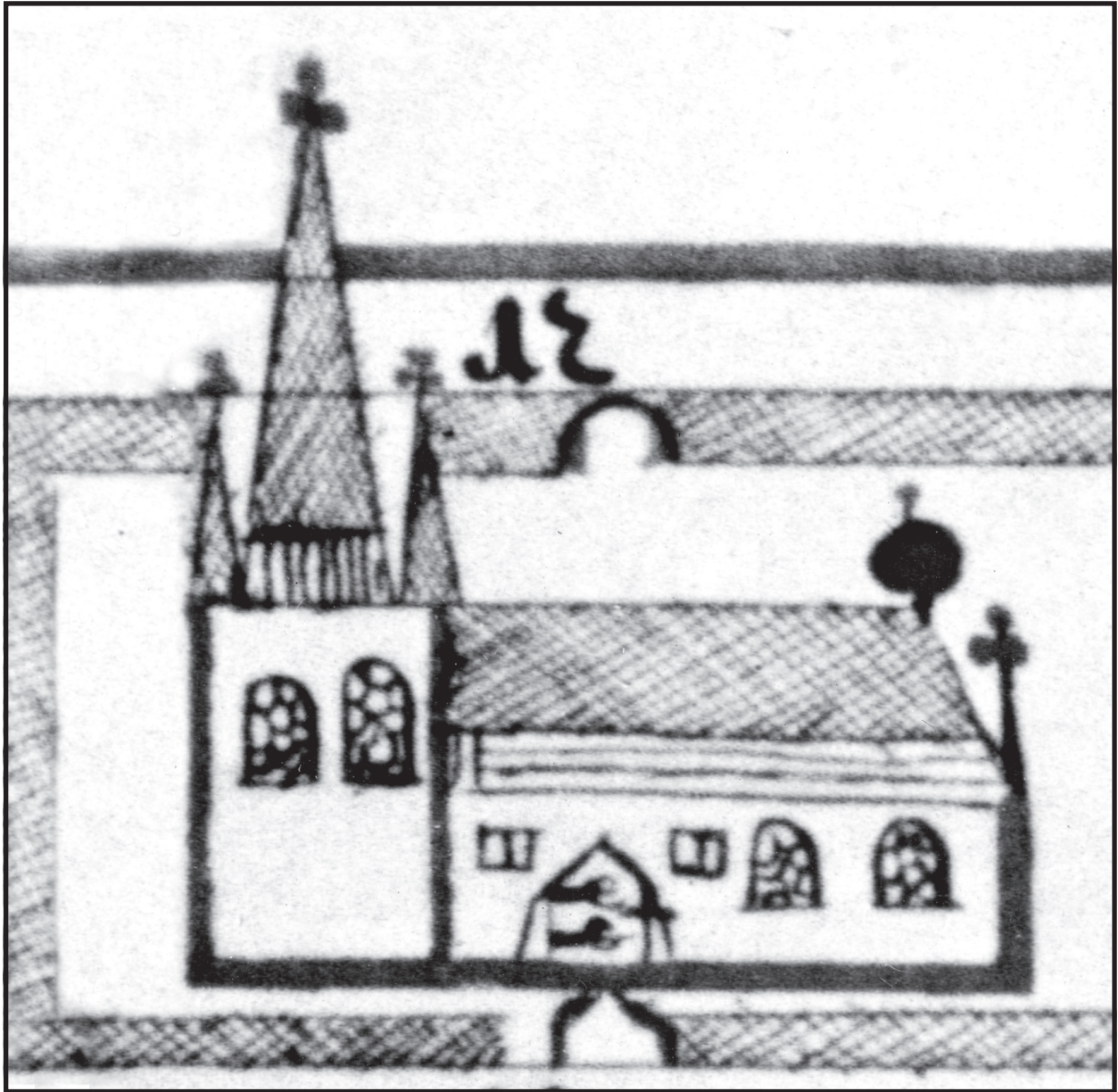
Den äldsta bevarande bilden som visar Gustavi kyrka i Göteborg återfinns på Kiätell Klasons karta över Göteborg från år 1644. Teckningen visar en kyrka som består av långhus och ett torn och kringgärdas av en kyrkogårdsmur. GSM.
